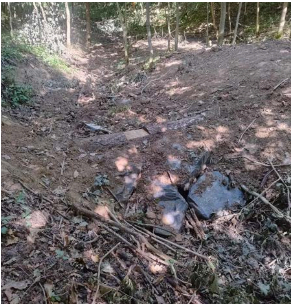
Obrázek 79: Příklad hrázky s kamenitým skluzem vhoňých pro řešení problematiky zahlubování strží. (Zdroj: Živá krajina, z. s., 2025)
