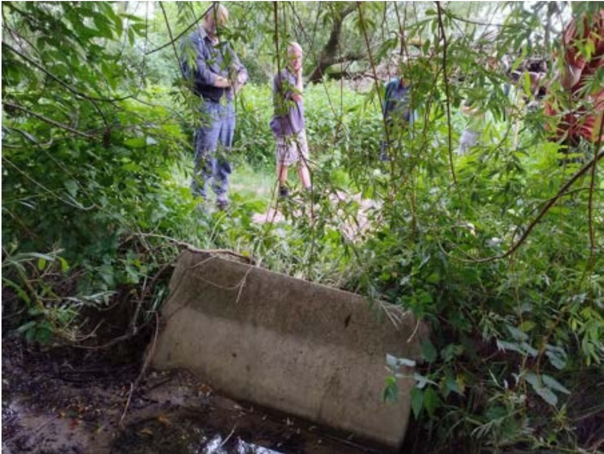
Obrázek 62: Zaklopení vtoku do zatrubnění směrem na Dětenice v Dětenického potoka. (Zdroj: Mapování v rámci studie, 2024)
